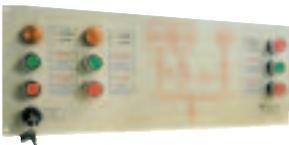
Suministro por dos transformadores que pueden estar en paralelo, y un generador o transformador de emergencia. El interruptor de emergencia sólo puede cerrar cuando los otros dos estén abiertos.
